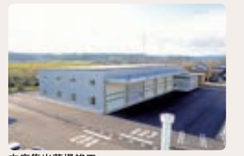
本店集出荷場竣工
